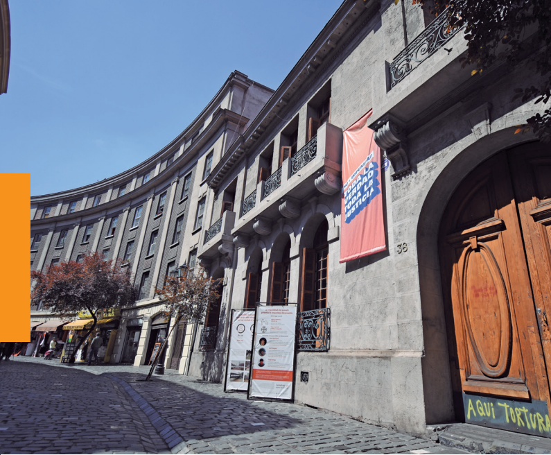
Fachada de Londres 38 Facade of Londres 38
